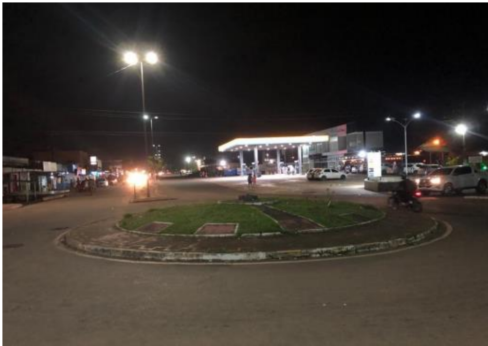
Figura 8 - Local de Iluminação de Destaque (Rotatória da Vila).
