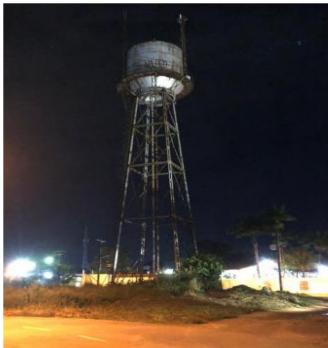
Figura 14 - Local de Iluminação de Destaque (Caixa D'Água Vila).
