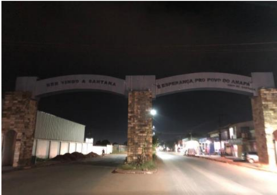
Figura 6 - Local de Iluminação de Destaque (Pórtico Fortaleza).
